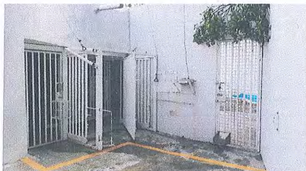
Sistema de puertas y barreras.
