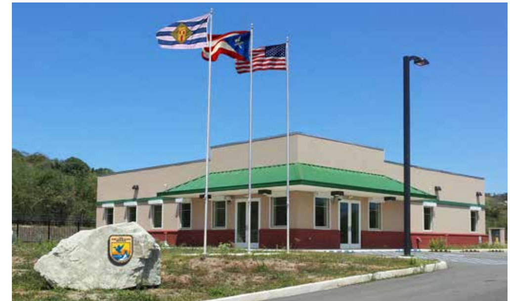
Vieques NWR new visitor center/administrative building. Nuevo Centro de Visitantes/Oficinas Admin. en el Refugio Nacional de Vida Silvestre de Vieques.
